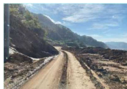
堆積した泥をよけ、車が通れるようになっています。
