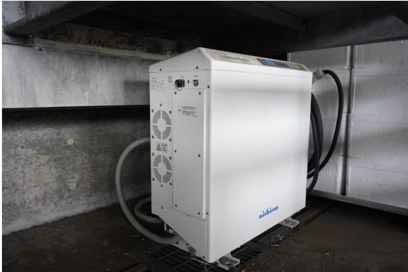
V2H (Vehicle to Home) システムを導入。災害時などに EV バスのバッテリーから電力を取り出し、分電盤を通じて事業所内の電力として使用できるようにする予定です。
