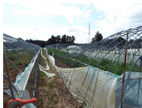
倒壊したビニールハウス（船橋農産物供給センター）
