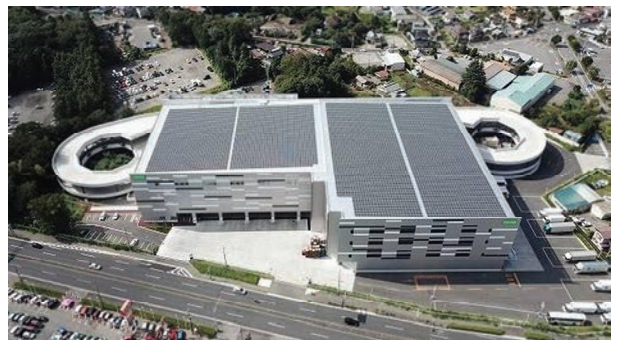
野田船形物流センターの屋上に設置した太陽光発電システム
