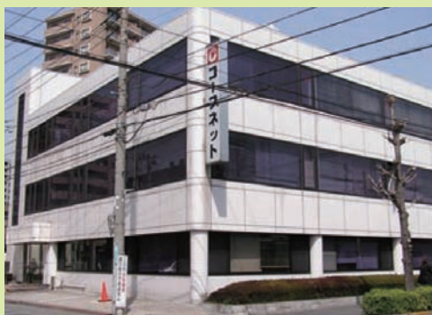
コープネット事業連合本館
