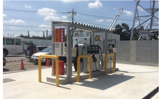
新たに設置した自家用燃料給油設備
