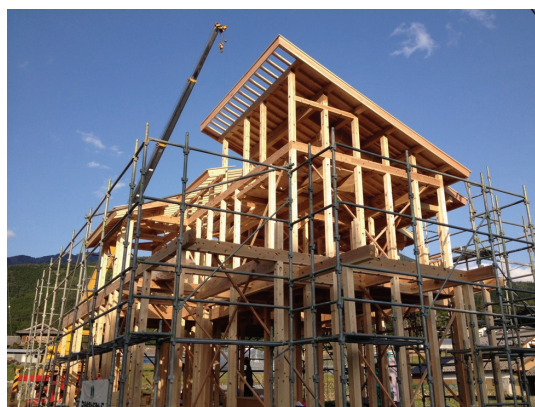
飛騨高山の建材を使用した建築中の住宅
