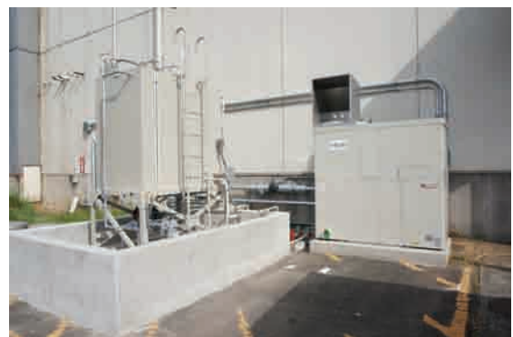
コープネットフーズ桶川生鮮センターに設置した 自家発電装置
