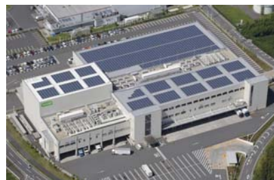
2013年に物流施設屋上に設置した太陽光発電パネル(千葉県印西市)
