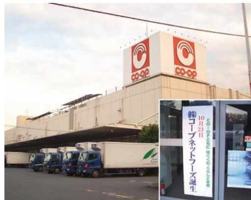
(株)コープネットフーズ 桶川生鮮センター
